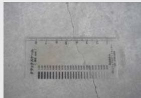
クラックスケールによるひび割れ幅の測定
