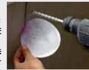
ドリル法による中性化深さ測定
